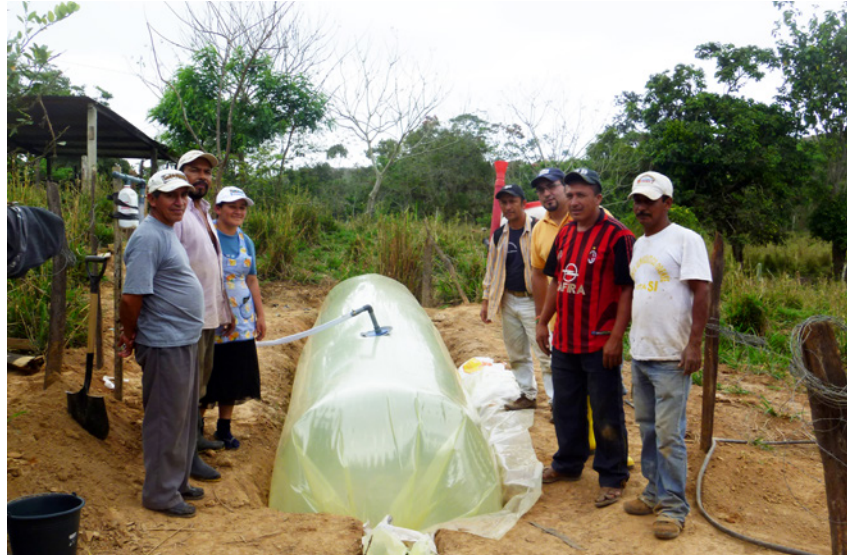
Ilustración 20. Instalación de un biodigestor tubular en Las Lajas, provincia de El Oro / Fuente: Parra, 2010
