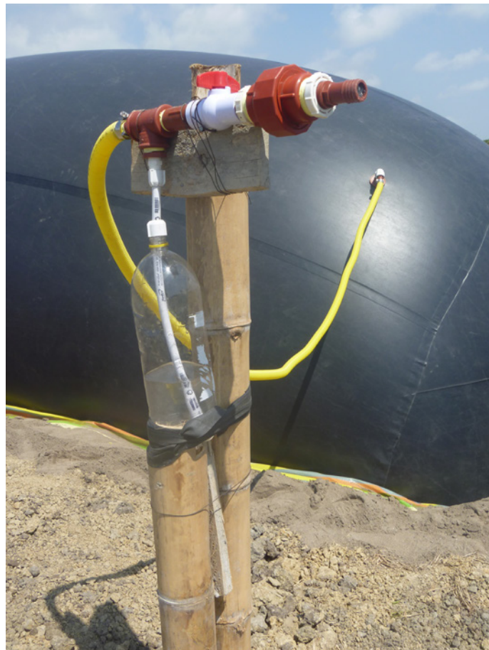
Ilustración 16. Conducción y válvula de alivio / Fuente: Parra, 2015
