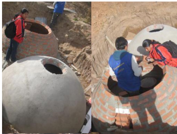
Ilustración 13. Biodigestor de domo fijo en viacaha, La Paz, Bolivia. / Fuente: Marti-Herrero, 2013
