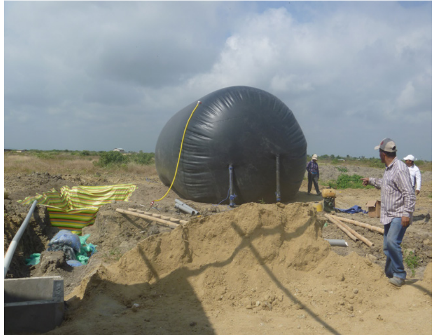
Ilustración 30. Proceso de instalación de un biodigestor en el cantón Huaquillas. Prov. El Oro / Fuente: Parra,2015
