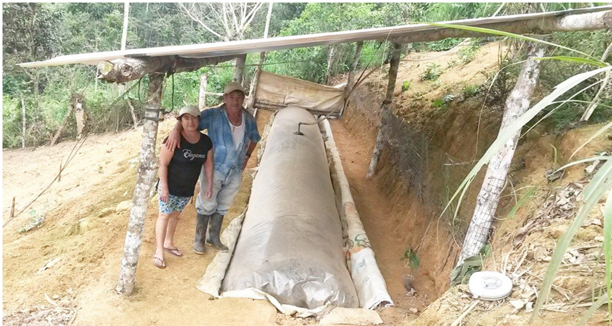
Ilustración 33. Visita de inspección mayor a los 120 días de instalación del biodigester / Fuente: Parra, 2013
