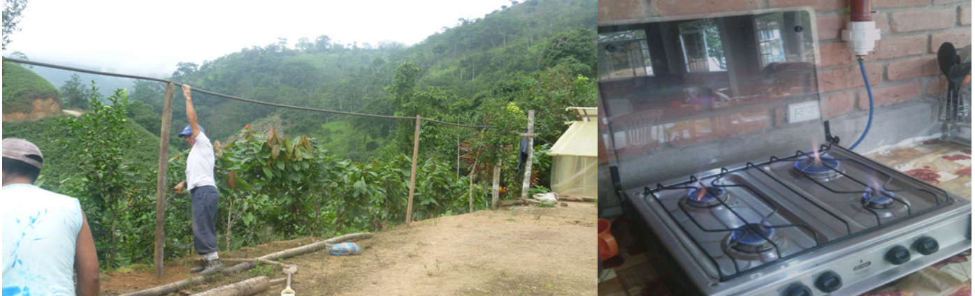
Ilustración 24. Conducción del biogás con manguera politubo de una pulgada de diámetro para su uso doméstico.
