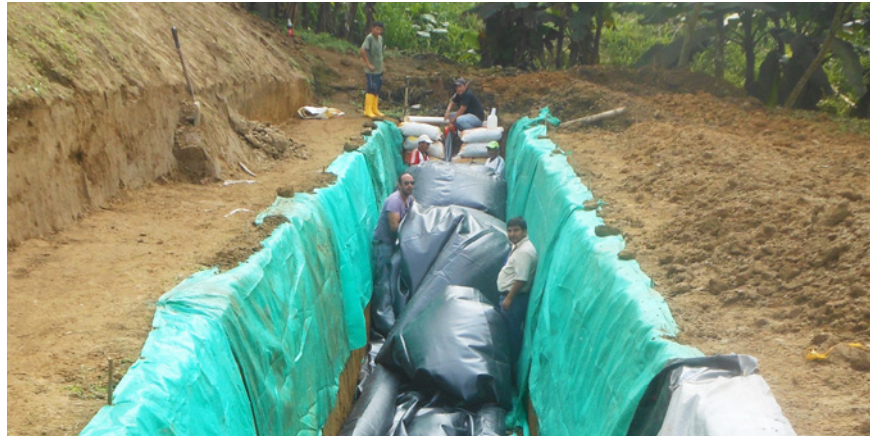
Ilustración 34. Instalación de un biodigestor.
